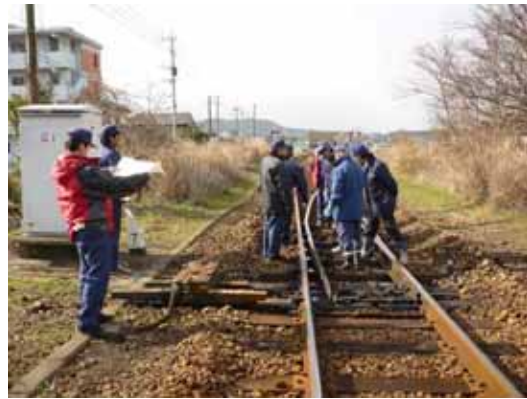
・ポイントの保守及び動作確認訓練
