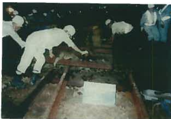
施工中 50N分岐器への 交換作業
