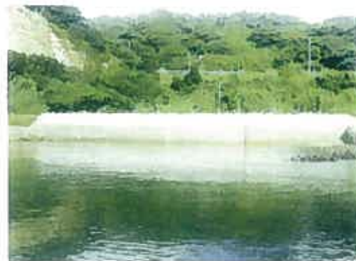
工事概要 海岸の擁壁に波返しを設置し、波による浸食から軌道設備の保護を行う。
