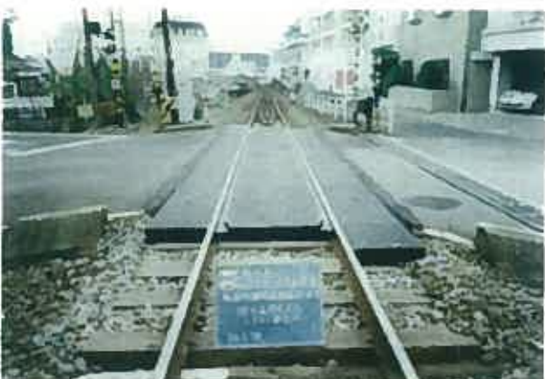
写真⑨ 工事：踏切舗装 実施年度：平成23年 実施所：〇〇
