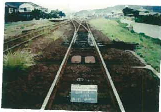
新設 分岐器の撤去 後の様子
