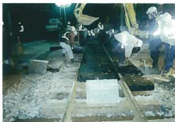
写真⑧ 工事：踏切舗装 実施年度：平成23年 実施所：〇〇
