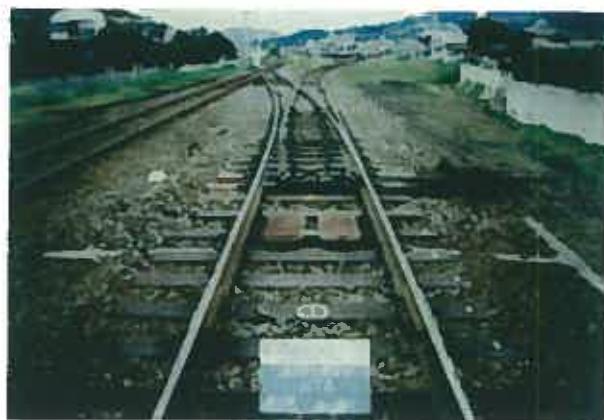
新設後 の様子
