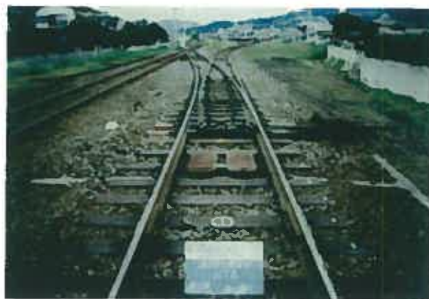
施工後 50N分岐器の 設置完了
