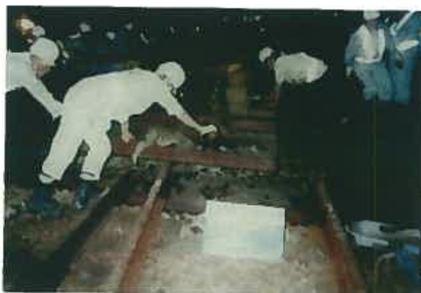
撤去中 の様子
