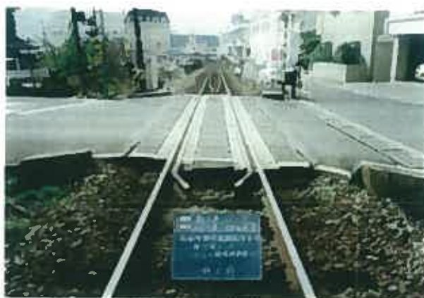
写真⑦ 工事：踏切舗装 実施年度：平成23年 実施所：〇〇
