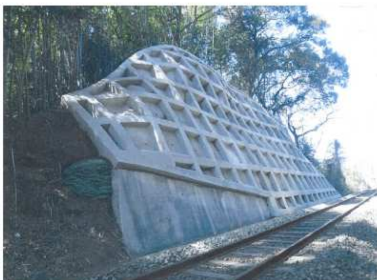
・東山代駅～里間の法面防護作業
