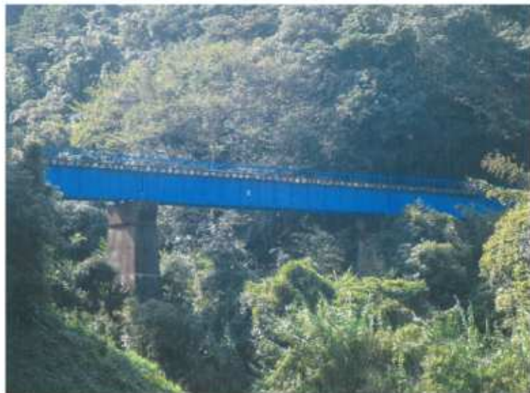
・西木場駅～東田平駅間坂瀬川橋梁塗装竣工(その2)
