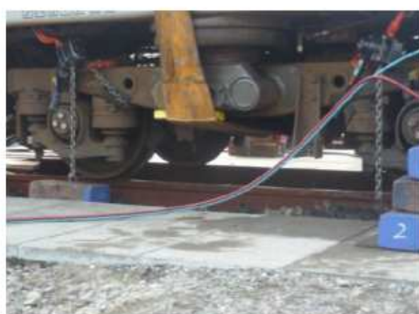
・油圧ジャッキによる載線
