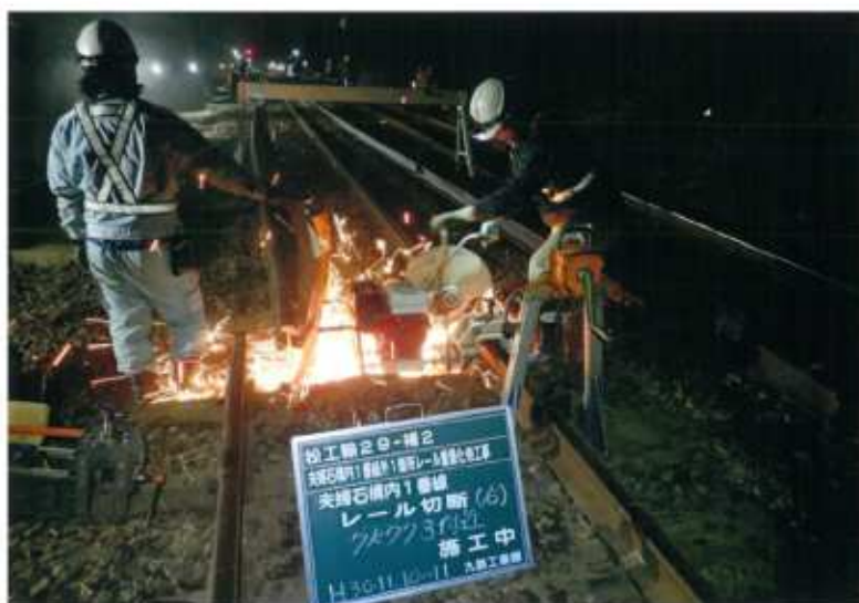
・夫婦石駅構内1番線レール切断作業
