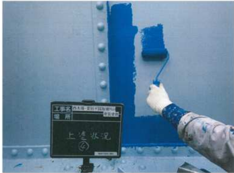
・西木場駅～東田平駅間坂瀬川橋梁塗装工事(その1)
