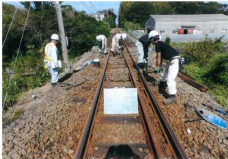
・中田平駅～たびら平戸口間木マクラギ交換作業
