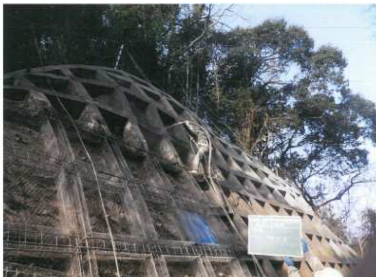
・波瀬駅～浦ノ崎駅間の法面防護作業
