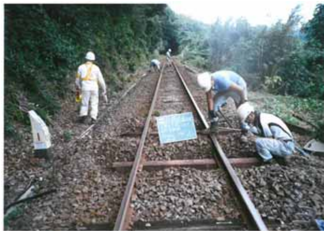
・有田～佐世保間の木マクラギ交換状況
