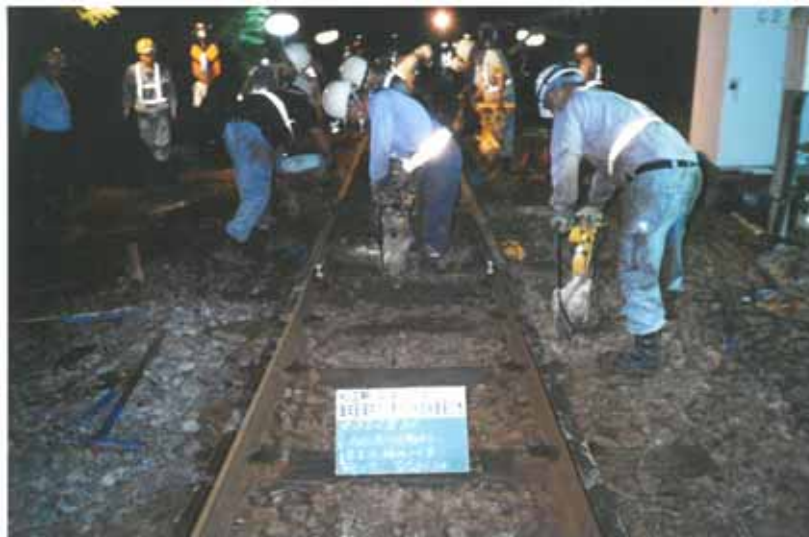
・分岐器交換作業
