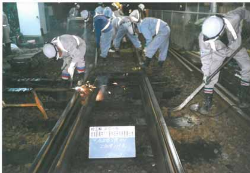
・分岐器交換作業
