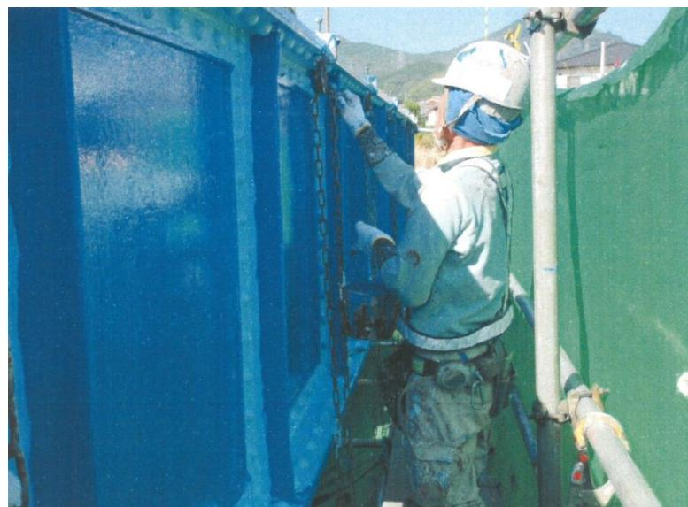
・新しい塗料を導入し、管内5つの橋の塗替えを行う。(塗装の耐久性を向上させ塗替え周期の延伸を図る)
