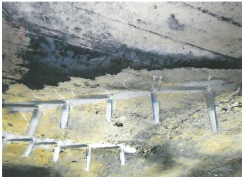
・トンネル覆工のクラック処理
